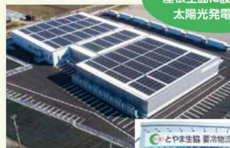
要冷物流センターの屋根全面に設置された太陽光発電パネル
